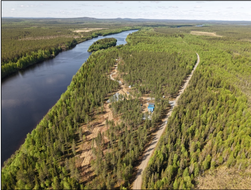
Kuva 4. Ilmakuva alueelta kesällä 2025 rakennustöiden alkuvaiheessa.
