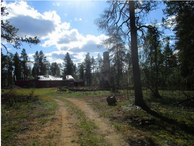
Kuva 6. Männistön talon pihapiiri, asuinrakennus on palanut.
