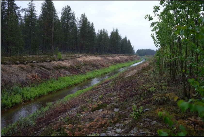
Kuva 2. Valtatien 4 lähetyksellä on iso kaivettu kanava.
