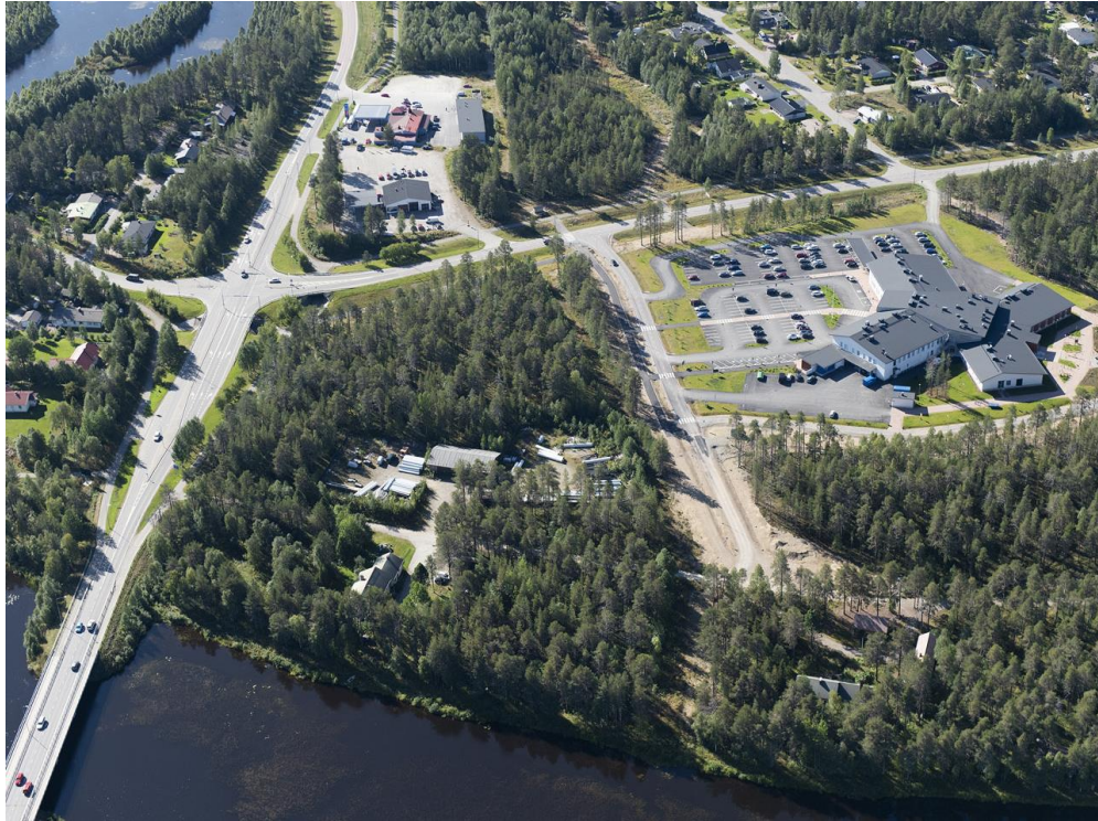
Kuva 20. Viistokuva alueesta kesältä 2021, kuvalla näkyy vielä puretut rakennukset Männistö ja Luirola, sekä keväällä 2024 purettava varastorakennus.
