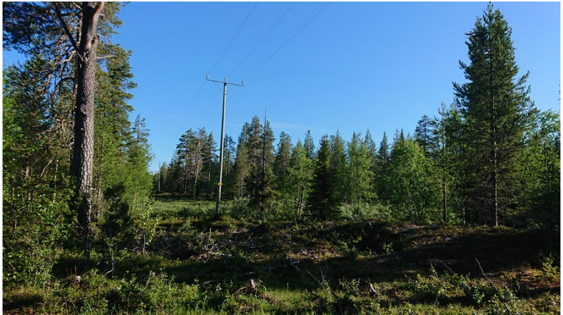
Kuva 35. Tankavaaran alueen läpi kulkee 20 kV sähkölinja. (Minna Takalo / FCG).
