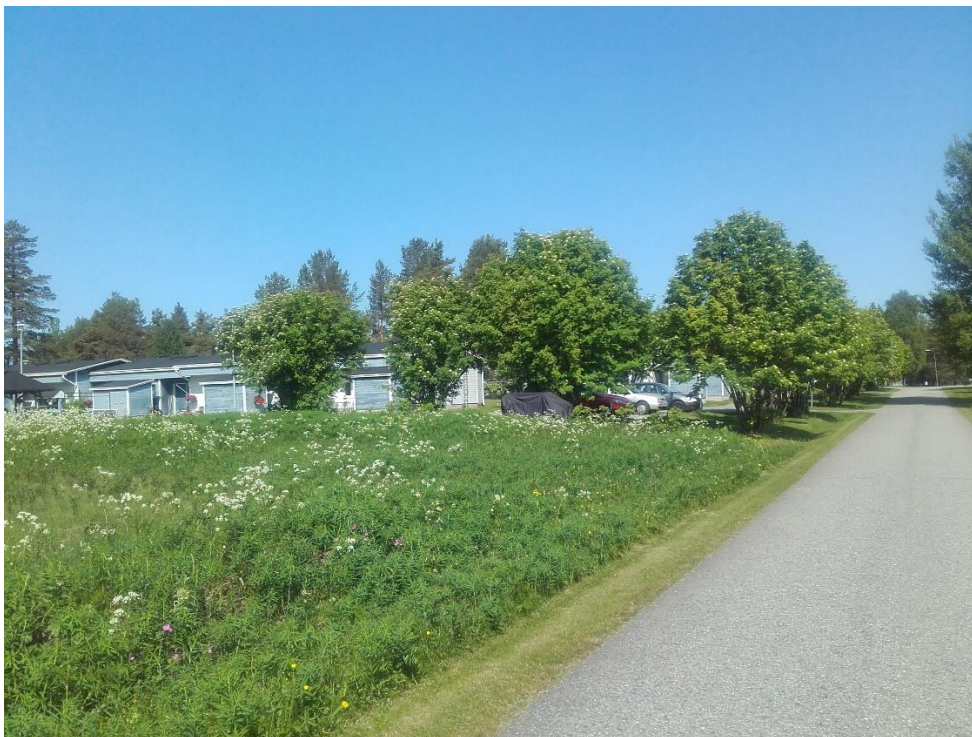
Kuva 9 vuonna 1970-1980 rakennettuja rivitaloja
