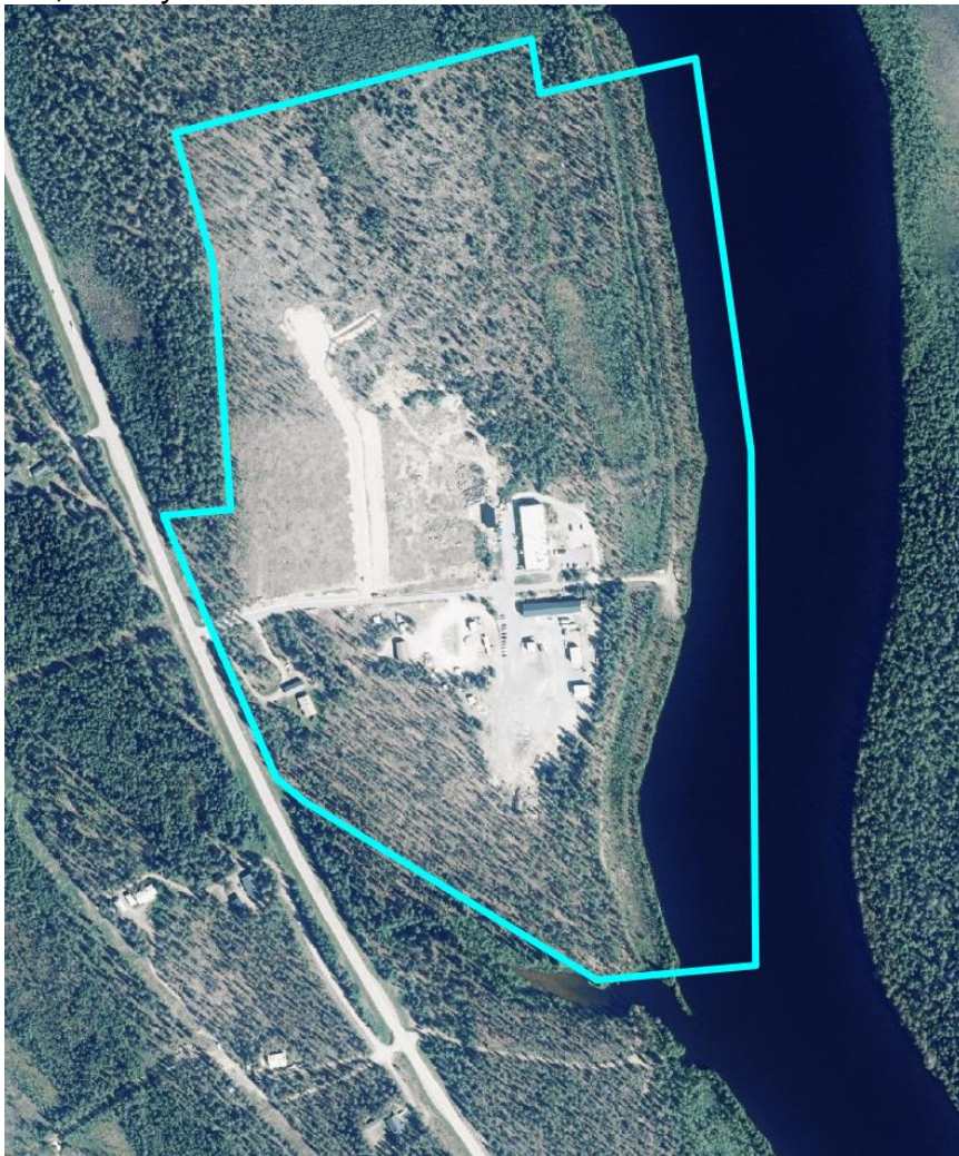
Kuva 4. Ilmakuva suunnittelualueelta © Maanmittauslaitos 2/2022
