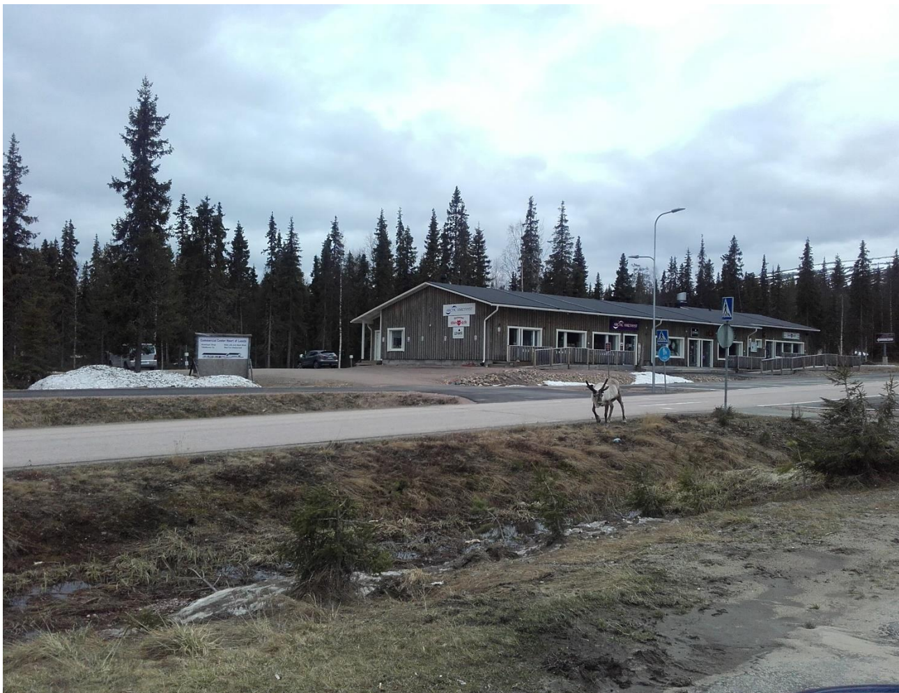
Kuvio 5. Rakennettu rakennuspaikka.
