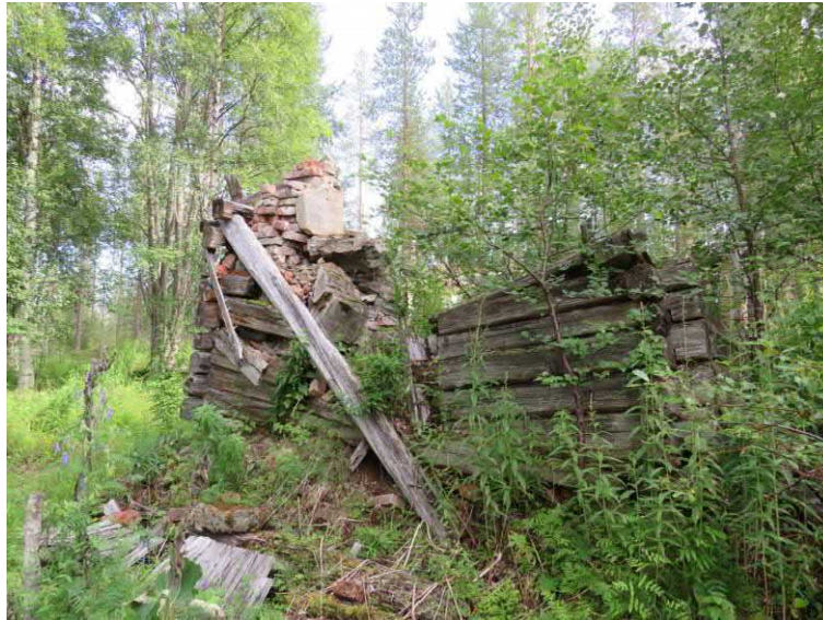
Navetan hirsikehikko, takaseinä koilliseen.
